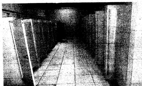
Foto 11 – Vestiário: cabines dos chuveiros
